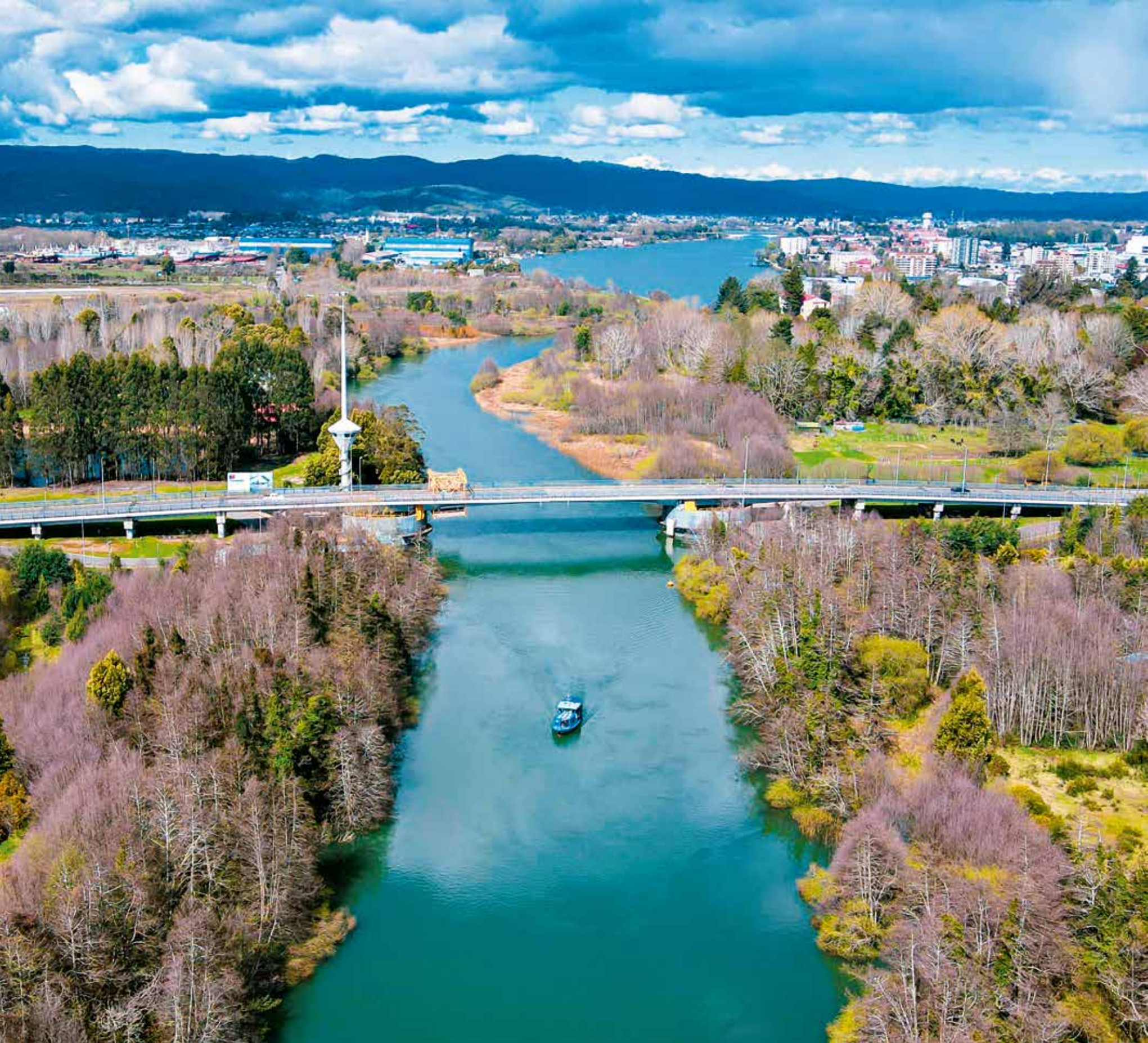
A 6045 - PUENTE CAU CAU VALDIVIA - XIV REGION
